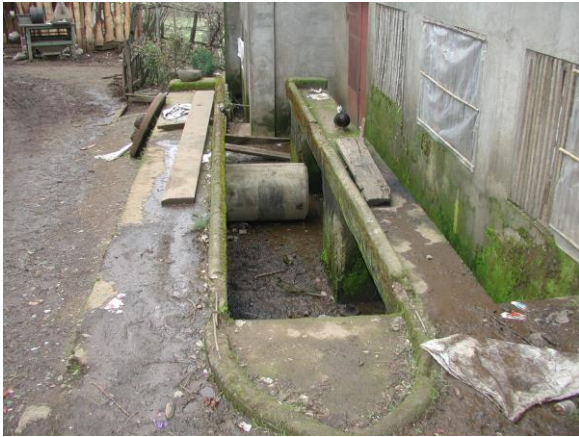
Pozo para reparación de vehículos (tecnestructura)
