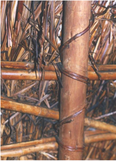
Fig. 20 . Detalle sistema constructivo de la ruka.
