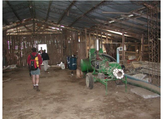
Fig. 28 . Vista interior de galpón, Treng – Treng.
