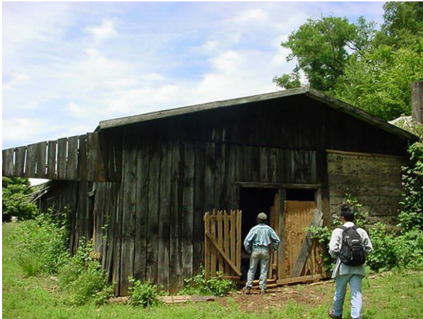
Fig. 31 . Galpón de estructura recuperable, Choin Lafquenche.
