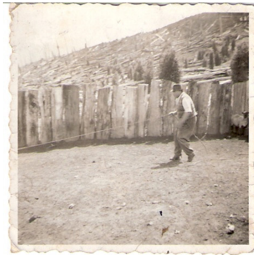
Figura 11. Fotografía de la década de los 50, donde se aprecia la deforestación provocada para abrir terrenos en Molulco.
