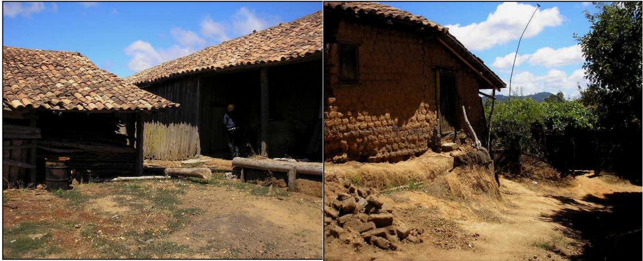
Foto 19 y 20. Estado actual de los galpones que alguna vez fueron grandes construcciones para la fabricación del vino.
