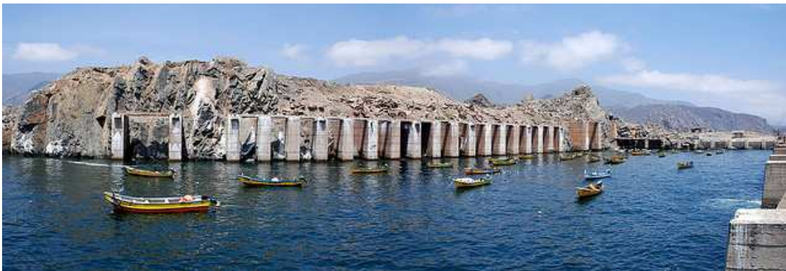
Figura 77 Rada de Ex mina El Tofo, actualmente usada solo por pescadores.
