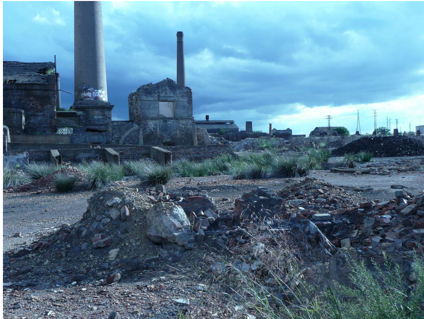
Figura 19 Estado actual de las antiguas instalaciones de la minería en Peñarroya, Córdoba, España
